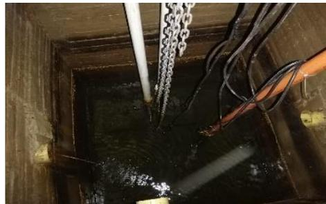
**+ CAJAS DE INSPECCIÓN DE AGUAS LLUVIAS (NIVEL FREÁTICO):** Se encuentra taponamiento por obstrucción con sedimento, óxido y residuos sólidos, se drenan las cajas con ayuda de la MOTOBOMBA para realizar sondeo, destaponamiento y limpieza.
