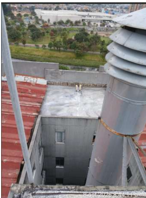
APLICACIÓN PRIMERA CAPA SISTEMA DE IMPERMEABILIZACIÓN T3
