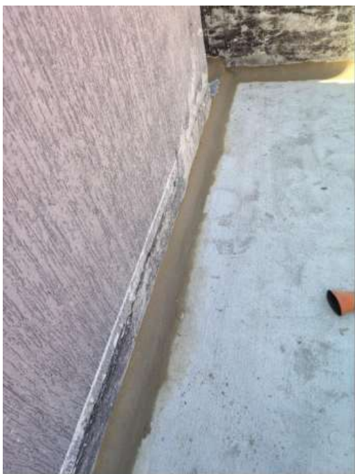
CONFORMACIÓN DE MEDICAÑA EN LOS VERTICES MURO PLACA TORRES 1 ,2 ,3
