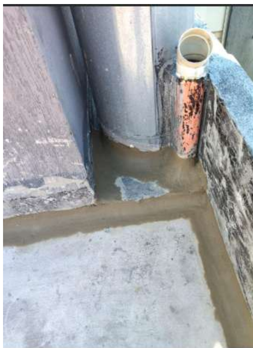
CONFORMACIÓN DE MEDICAÑA EN LOS VERTICES MURO PLACA TORRES 1 ,2 ,3
