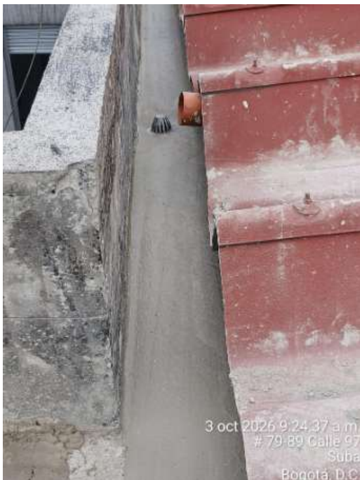
APLICACIÓN DE MORTERO PENDIENTADO EN SENDEROS PLACA CUBIERTA T 1,2,3
