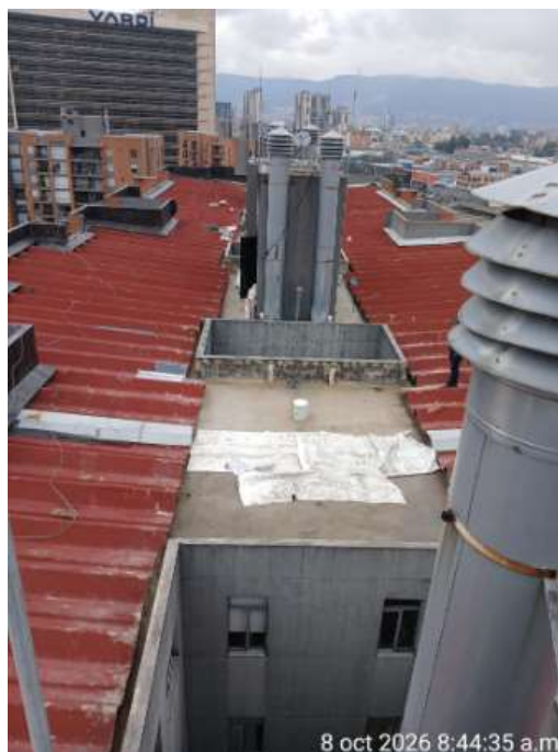
MORTERO PENDIENTADO SOBRE PLACA SENDERO T 2
